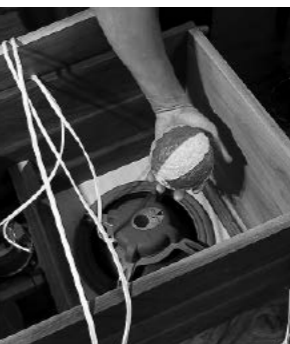
江川三郎氏の手法。定在波対策として紙風船を1個入れてみる
